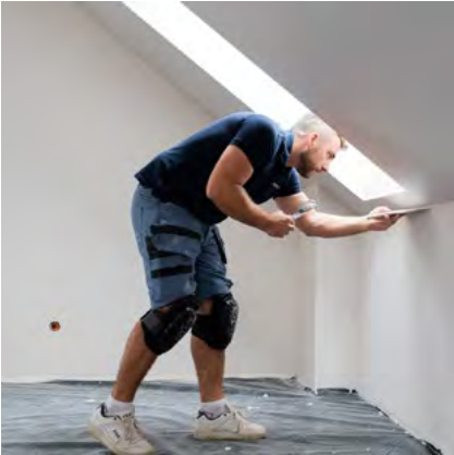
Gładzie na ścianach i sufitach
