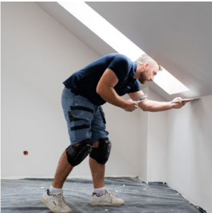
Gładzie na ścianach i sufitach
